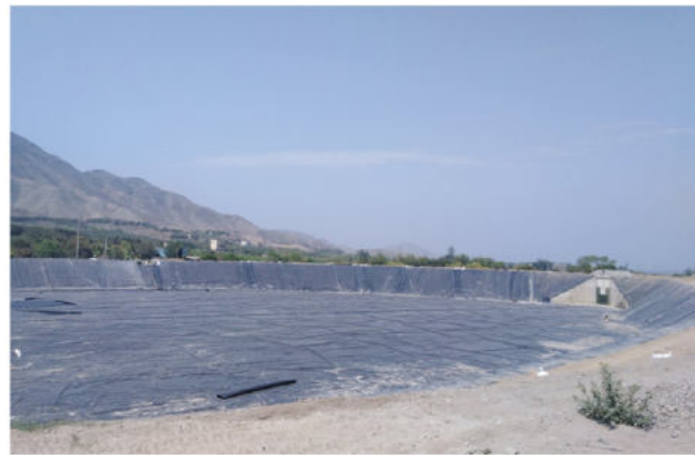
SERVICIO DE INSTALACION DE RESERVORIO 19000 M2
