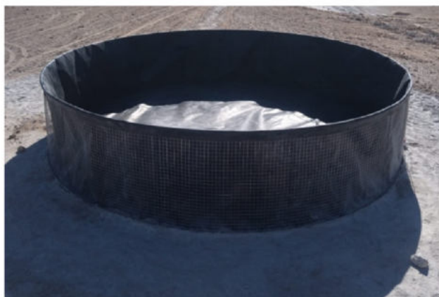
INSTALACION DE GEOTANQUES DIAMETRO 7 M
