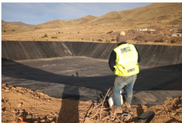
SERVICIO DE INSTALACION 3000 M2
