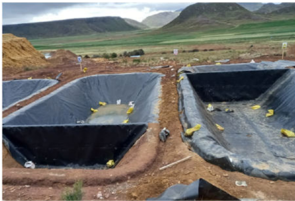
RESERVORIO MINA 3000 M2 INSTALACION DE GEOMEMBRANA
