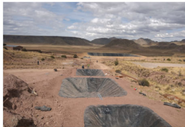
SERVICIO DE INSTALACION DE GEOMEMBRANA HDPE
