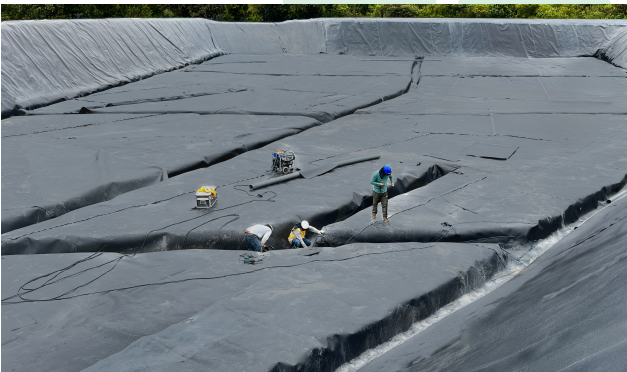
SERVICIO DE INSTALACIÓN 15000 M2 EMPRESA INDUSTRIAL BANDEJA HDPE
