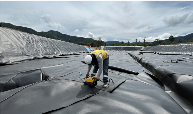
RESERVORIO MINA 19000 M2 INSTALACIÓN DE GEOMEMBRANA
