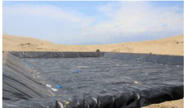
SERVICIO DE INSTALACIÓN DE RESERVORIO 12000 M2
