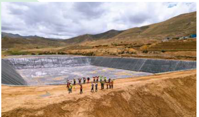
SERVICIO DE INSTALACIÓN DE GEOMEMBRANA HDPE
