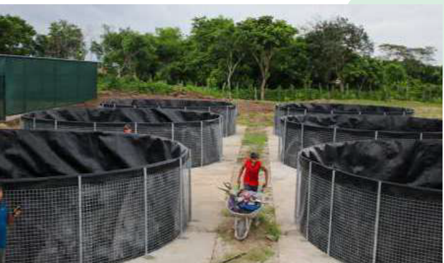
INSTALACIÓN DE 06 GEOTANQUES
